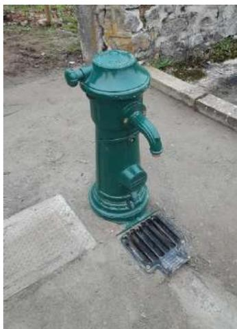
Le remplacement du robinet provisoire, peu adapté, du point d'eau par une borne incongelable plus fonctionnelle était prévu à l'été 2022 mais a dû être reporté en raison d'une rupture de stock chez le fournisseur. Ce remplacement vient d'être réalisé au début du mois de Janvier.
